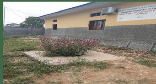
Laboratoire provincial de Kisangani Province de la Tshopo
