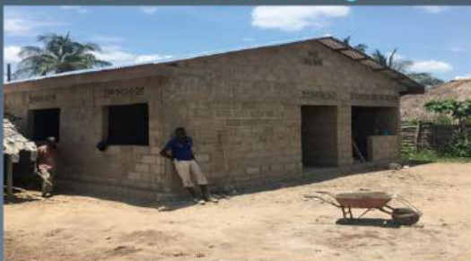
Fondation bâtiment CS Mbelo
